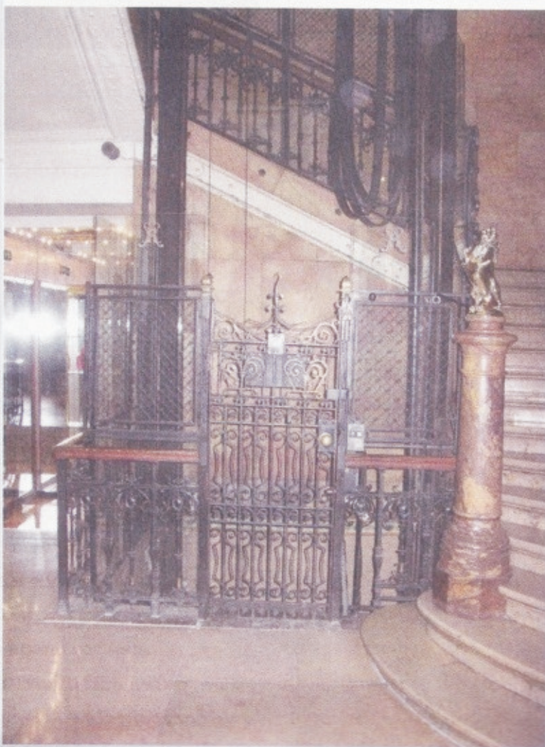
Les cabines doivent disposer d'un rideau de sécurité électronique ou d'une porte cabine empêchant d'être en contact physique avec l'extérieur
